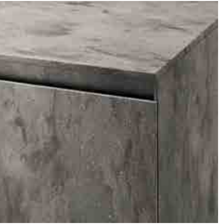
IT_ Versione tutta rivestita in Corian: ante con bordi verticali dritti in appoggio sui fianchi + Top bordo dritto.
